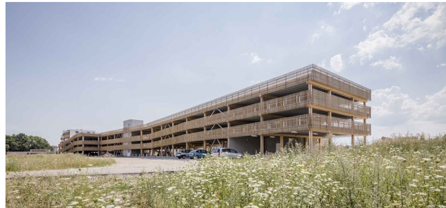
Parking de la ZAC des Rives du Bohrie à Ostwald (Architecte : Jourda Architectes)
