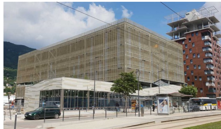
Parking de la Presqu'Île à Grenoble (Architecte : Agence Patrick Chavannes – AAUPC)
