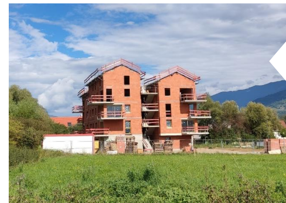
À Crolles, la construction de Mosaïque à l'arrière plan et le terrain du projet Mosaïcoop au premier plan
