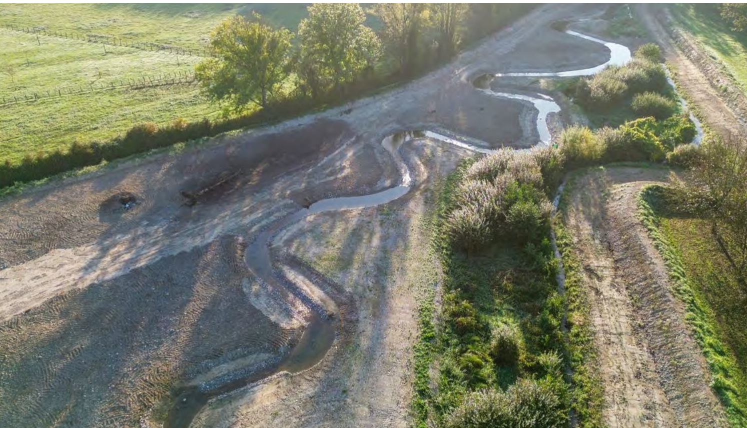
Travaux de restauration de la Grande Rigole à Poliénas
