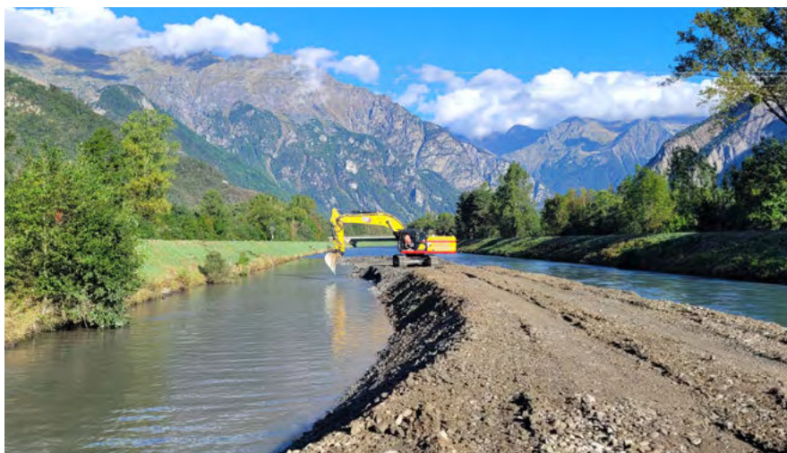
Travaux prioritaires de renforcement de la digue du Bourg d'Oisans
